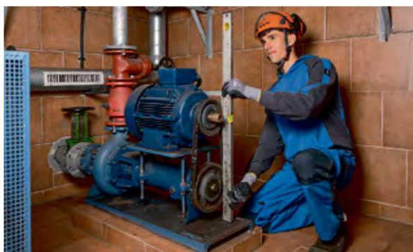
Sascha Werlitz wechselt einen Keilriemen an einer Pumpe im Hauptpumpwerk Technologie- und Gewerbepark Eberswalde ...
