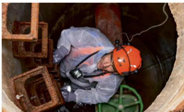
... und kontrolliert den Schieber im Schacht auf Funktionsfähigkeit.
